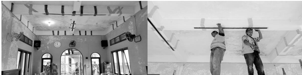
Gambar 6. pelat CFRP sudah selesai terpasang pada balok HKBP titi layang.
