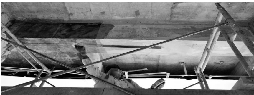
Gambar 2. Perkuatan Struktur Balokk dengan CFRP Wrapp
