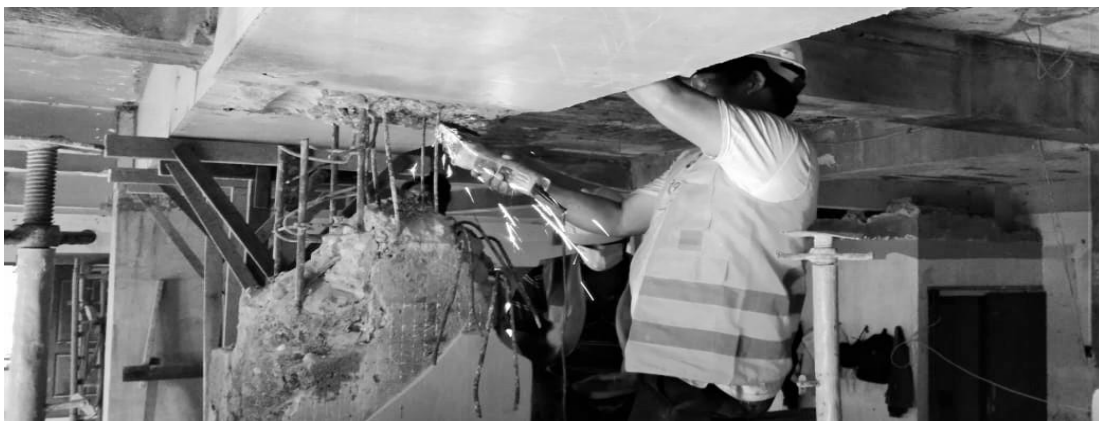
Gambar 3. Proses Pemotongan Kolom
