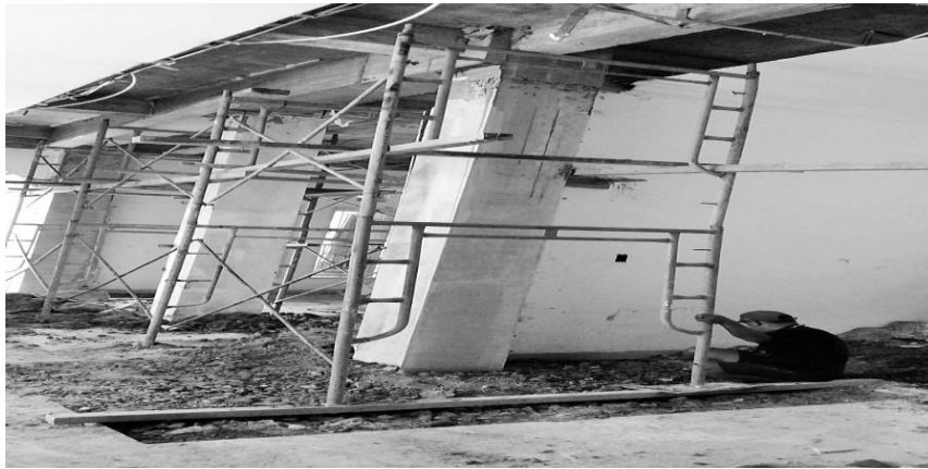
Gambar 1. Perkuatan Struktur Kolom
